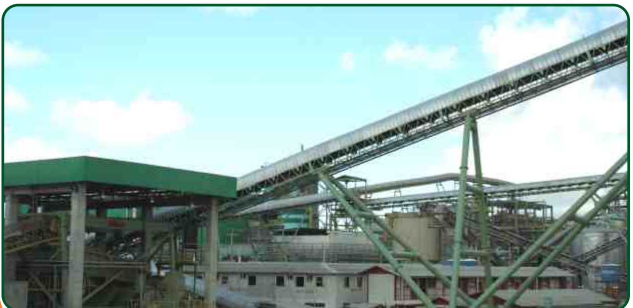
Transportadores de cavaco da área de picagem.
