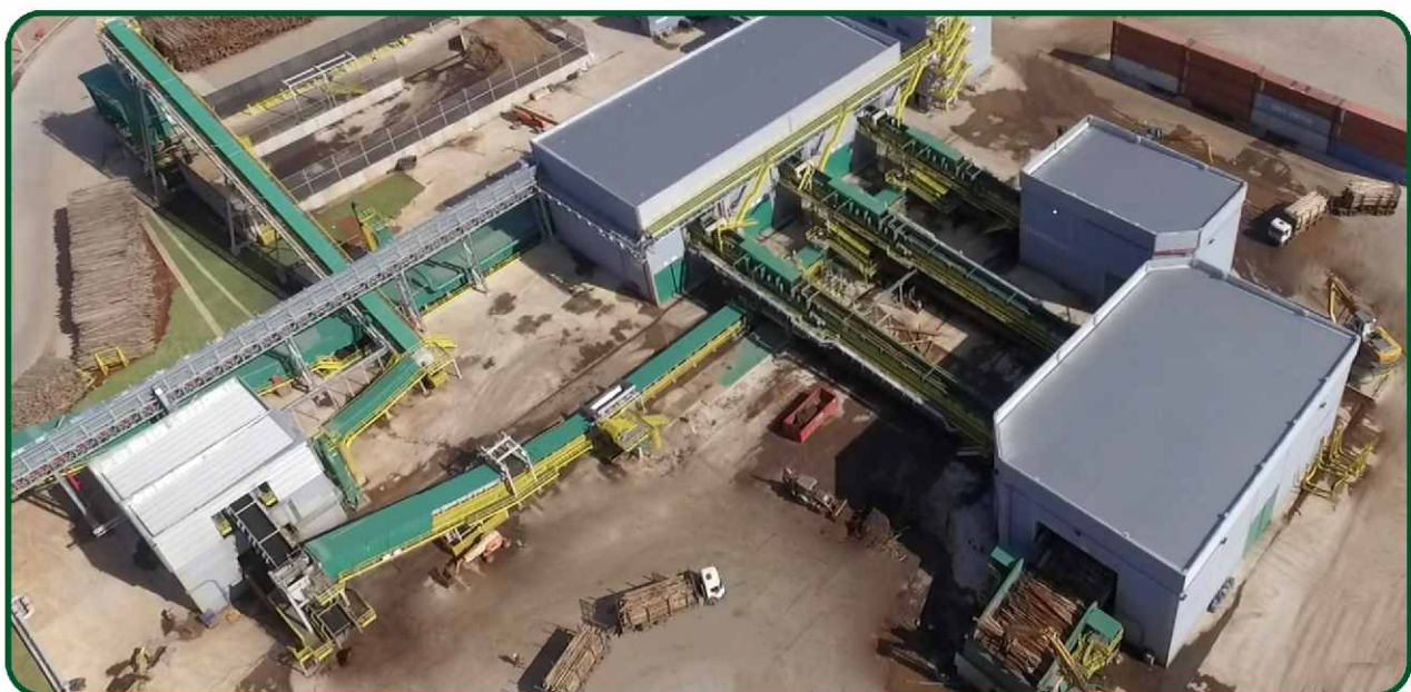
Chipping lines acoustic isolation buildings / Prédios de isolamento acústico das linhas de picagem
