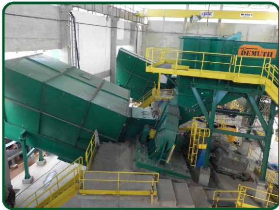
Chipper Building / Prédio dos Picadores
