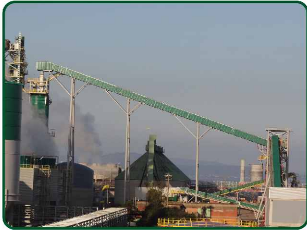
Belt Conveyor Digester Feeding Transportador de Alimentação da Caldeira
