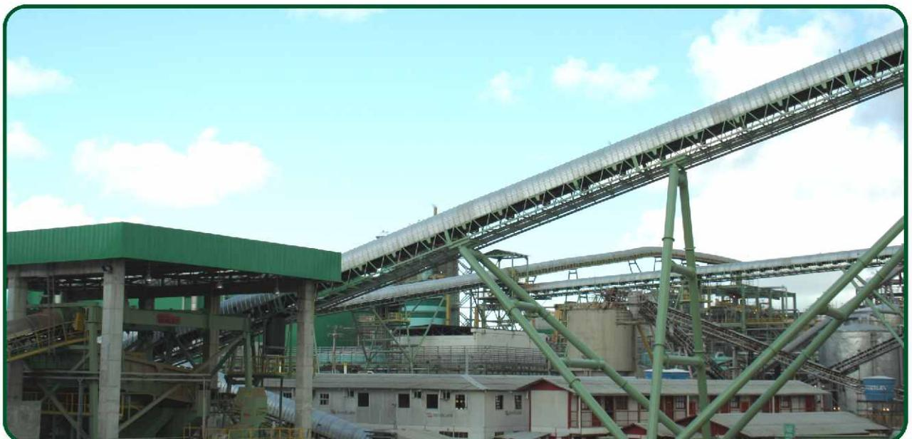
Chip conveyors at the chipping area / Transportadores de cavaco da área de picagem
