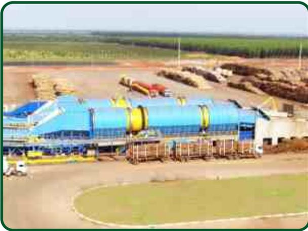
O pátio de madeira **DEMUTH** é composto por duas linhas de picagem com tambor descascador, estação de peneiramento com duas peneiras para 1.000 m<sup>3</sup> de cavacos por hora, estação de picagem de casca, armazenagem e mais de 2.500m de transportadores.
