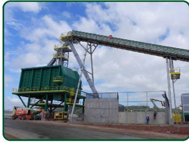
Bark Storage / Silo de Cascas
