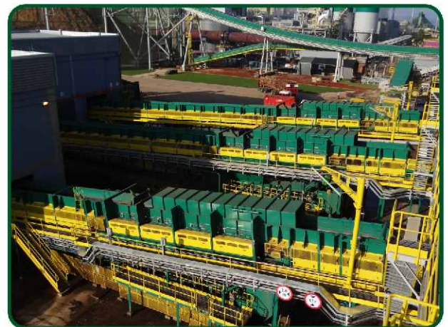
3 Chipping Lines / 3 Linhas de Picagem
