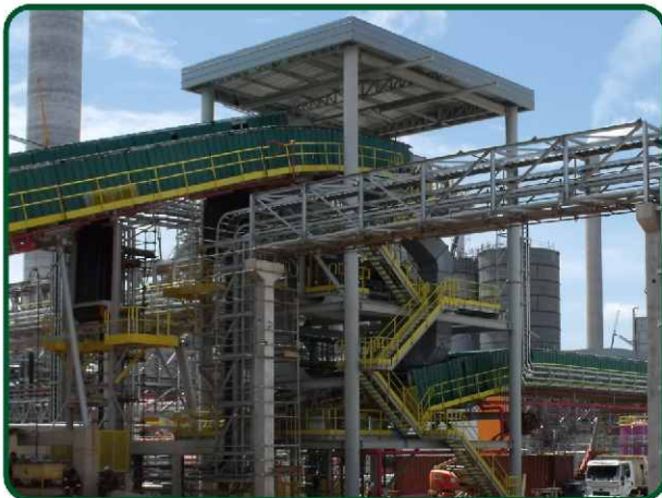
Transfer Tower / Torre de Transferência
