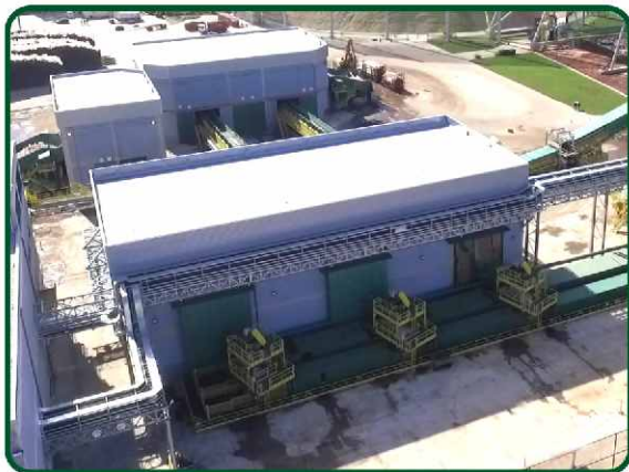
Discharge Disc Chipper / Saída dos Picadores
