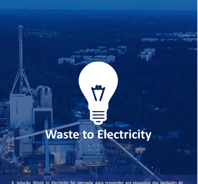
A solução *Waste to Electricity* foi pensada para responder aos requisitos das unidades de produção de energia no que diz respeito á produção e manipulação de combustível derivado de resíduos *CDR* 's. O processo engloba: recepção e armazenamento de resíduos, transporte e alimentação à caldeira, bem como a remoção e armazenamento da cinza. O combustível produzido pelo TYRANNOSAURUS® *Waste to Electricity* é de excelente qualidade para a combustão em caldeiras *fluid bed boiler*'s.
